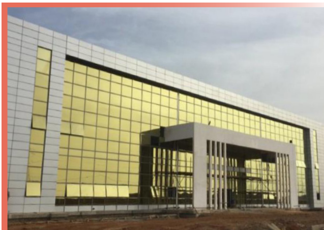
Un bâtiment de la Plateforme Industrielle Internationale de Diamniadio
